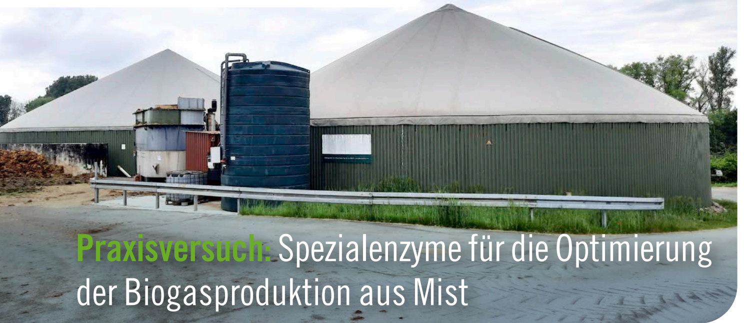
Abbildung 1: Biogasanlage der kaim agrar-Energie GmbH & Co.KG
